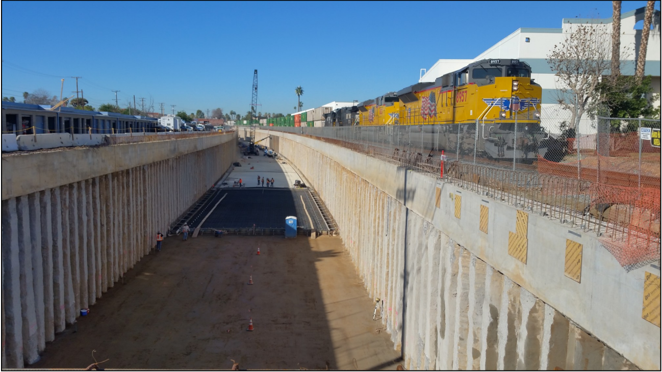
上圖，一輛太平洋聯合鐵路列車正從旁邊臨時鐵路軌道上駛過，而工人們正在地下槽底部鋪設鋼筋水泥路面。
