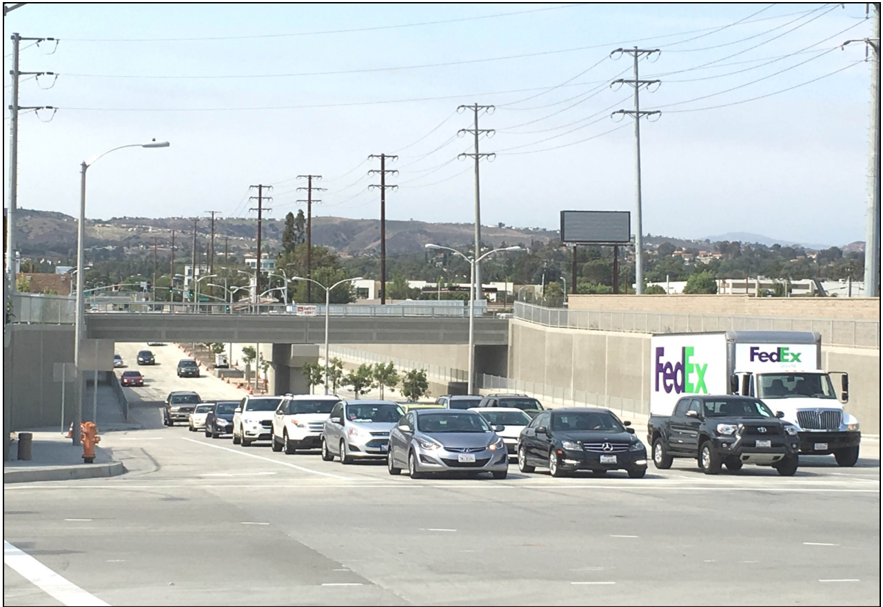
汽車駛過Nogales Street新的六線地下通路，把全國最危險的鐵路公路平交道口之一的安全徹底改善。
