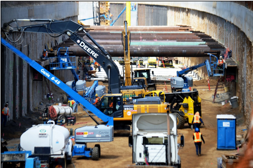
左圖，工人們正在為約2.2英里長的聖蓋博谷地下槽工程建造高約30英尺高的防護牆。
